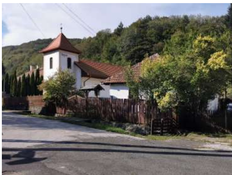
A Petőfi Sándor utca elágazásánál található római katolikus templom
